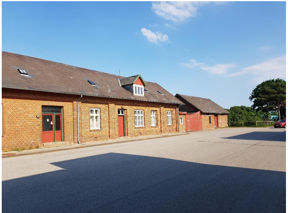
Figur 1: Stationsbygningen, Lem St.
